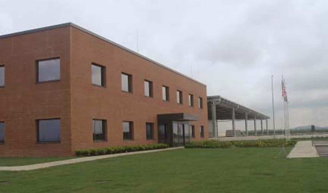
A telep 33 hektáron terül el, az épület alapterülete 24000 négyzetméter
