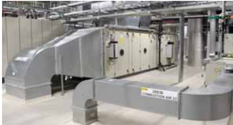
Das neue DAF Engine Test Center, mit dem rund 80 weitere Facharbeitsplätze geschaffen wurden, verfügt über drei Etagen. Das Untergeschoss beherbergt technische Anlagen. Die Prüfstände und Testbereiche befinden sich im Erdgeschoss, während der gesamte erste Stock von Vorrichtungen zur Luft- und Wasseraufbereitung eingenommen wird. Diese Anlagen können pro Stunde bis zu 36.000 m³ Luft pro Prüfstand fördern, die Motoren mit Wasser kühlen, geregelte Verbrennungsluft zuführen und überwachte Abgase bei reduziertem Lärmpegel abführen.
